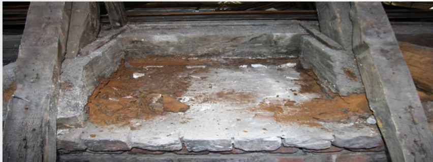
Eine sanierte Verbindung
