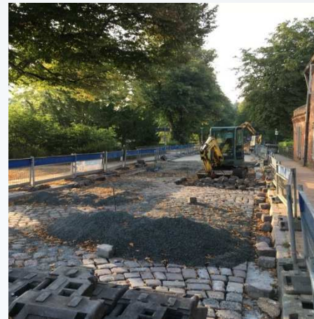
Baustelle vor dem Pulvermacherhaus
