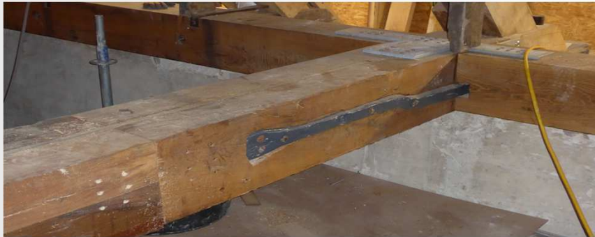
Eine sanierte Verbindung
