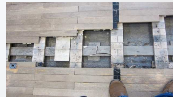
Gebrochene Unterkonstruktion
