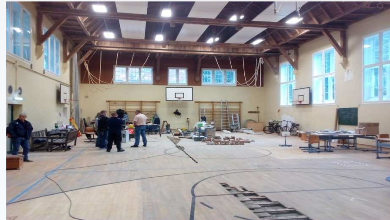
Turnhalle – derzeit stillgelegt
